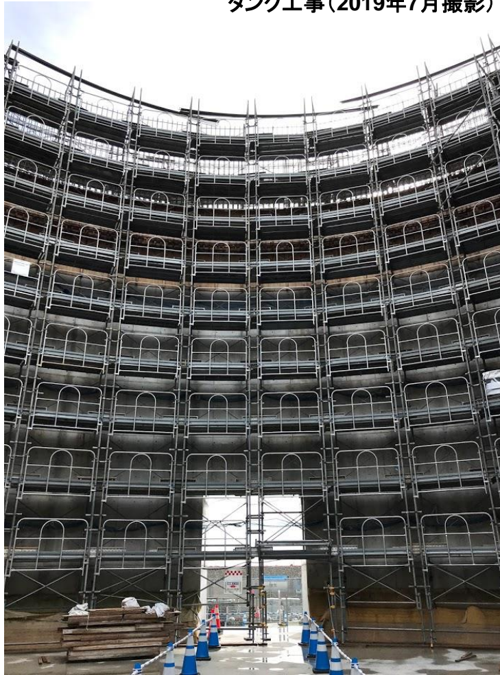
タンク工事(2019年7月撮影)
