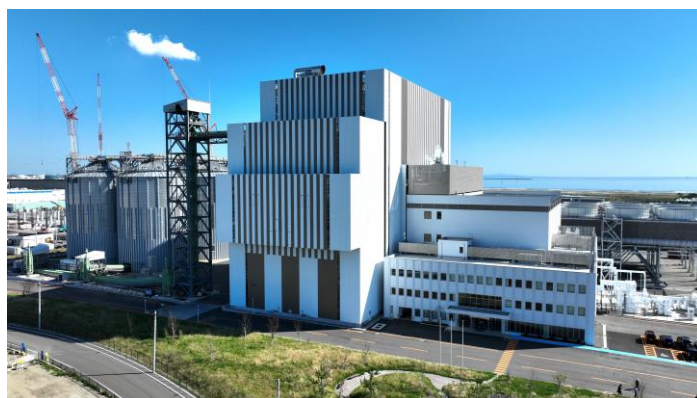
（杜の都バイオマス発電所／2023年10月撮影）
